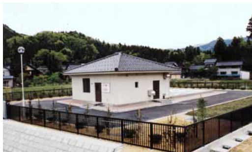
黒川浄化センター
