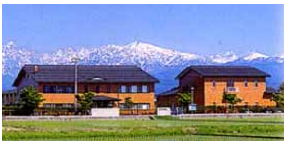
中新川浄化センター
